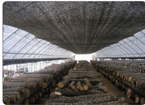
내부 2중차광망 설치
